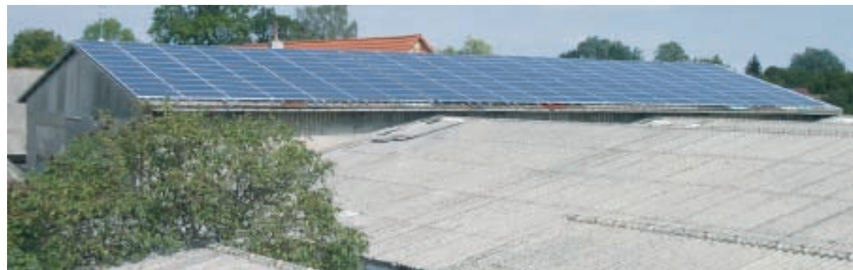
Solaranlage auf einer Bergehalle in Audenhain
