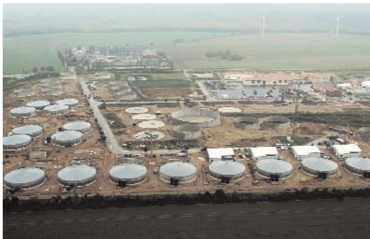
Blick über die Baustelle des weltgrößten Biogasparke in Penkun, der von EnviTec Biogas errichtet wird
