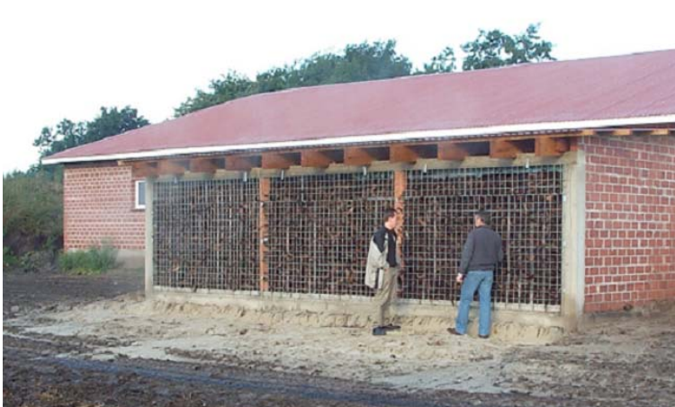
Außenwand eines dreistufigen Filters
